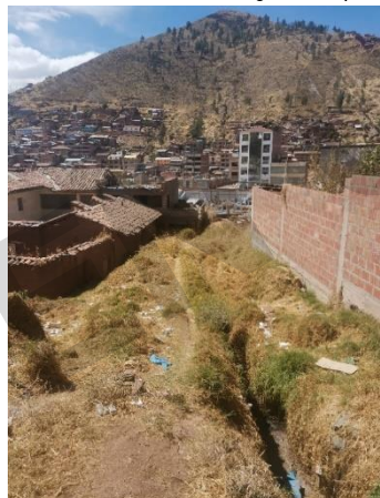
Imagen N° 36: Canal abierto en el área de servidumbre entre las manzanas A,P y S ´ de la A.P.V. Manahuañoncca Segunda Etapa
