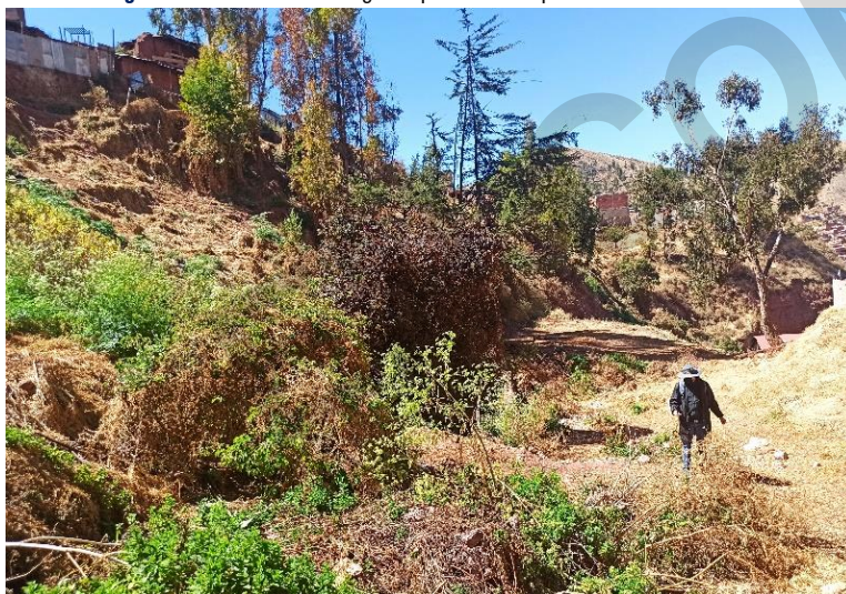
Imagen N° 48: Vista de la margen izquierda de la quebrada Manahuañoncca
