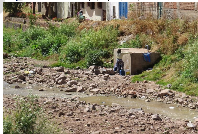
Imagen N° 50: Vista del río Huancaro que pasa por la parte baja del ámbito de intervención
