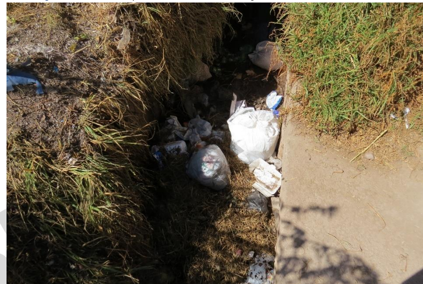
Imagen N° 70: Punto acopio de RRSS en el canal de agua del ámbito de la ZRESA04
