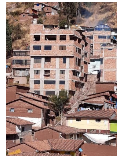
Imagen N° 26: Edificaciones de tres niveles hacia la vía principal con dos subniveles hacia la pendiente del terreno, contándose cinco niveles de edificación en total
