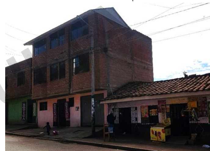
Imagen N° 31: Poste de alumbrado público instalado dentro de la acera disminuyendo y obstaculizando el tránsito peatonal
