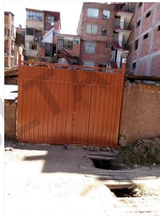
Imagen N° 37: Canal natural cubierto atraviesa por debajo del lote 1 de la Manzana T ´ de la A.P.V Villa Unión Huancaro, calle S/N 02 desembocando en el río Huancaro
