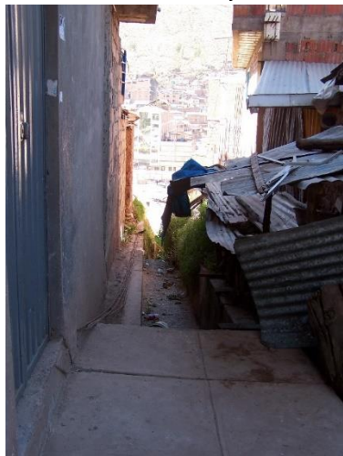
Imagen N° 35: Pasaje de servidumbre para canal de agua, ubicado entre las manzanas "A", "P" y "S"
