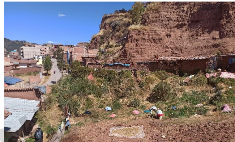
Imagen N° 49: Vista de la margen derecha de la quebrada Manahuañoncca
